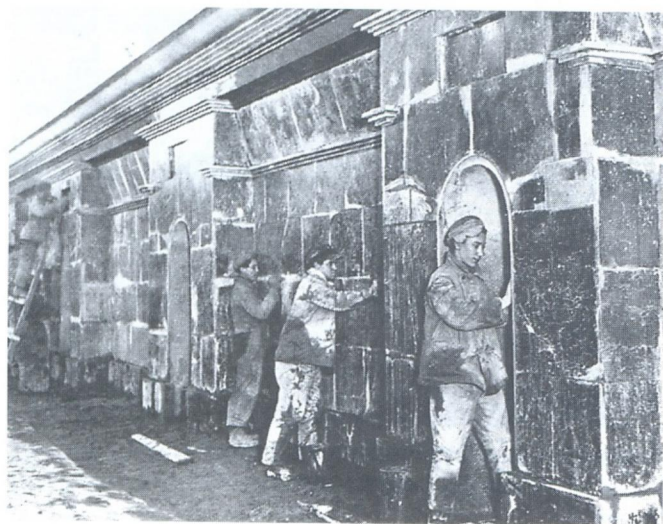
Отделка первых станций московского метро
