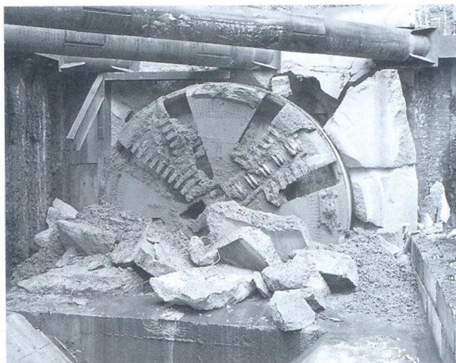
Современный проходческий щит только что пробил туннель к новой станции метро
