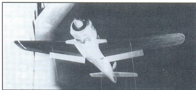
Продувка в аэродинамической трубе FW 190 с новым крылом увеличенной площади
