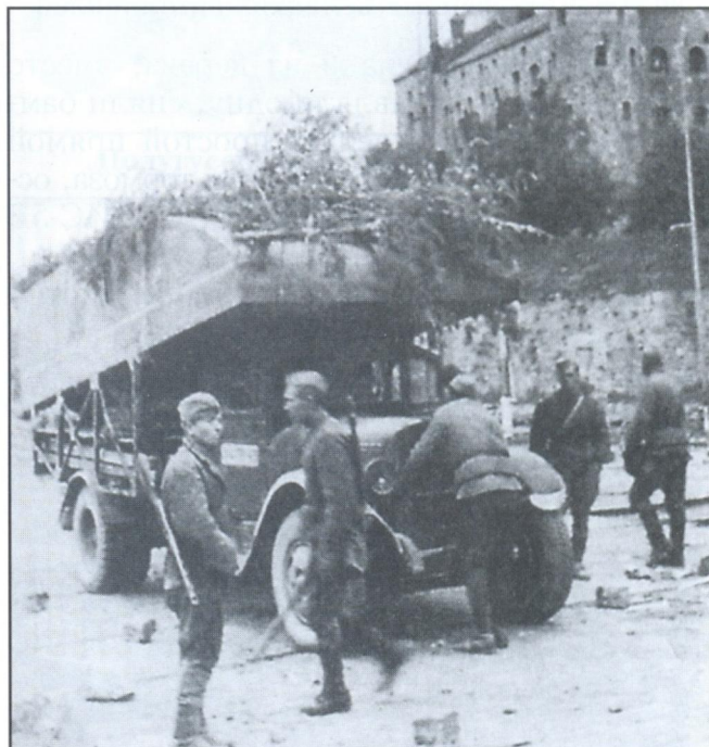
Саперный ЗИС-5 перевозит понтон наплавного моста
